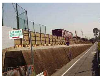
《福井駅法面を補修②》
