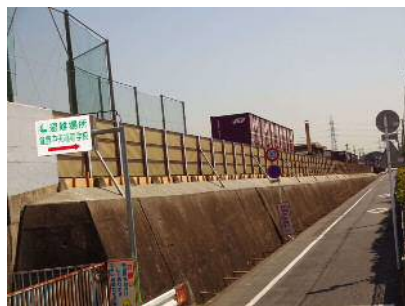
《福井駅法面を補修②》
