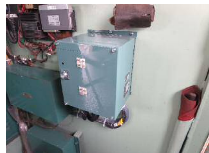
《運転状況記録装置》
